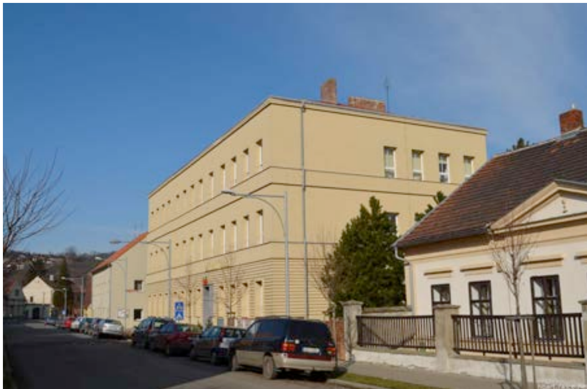
Opravená budova základní školy
