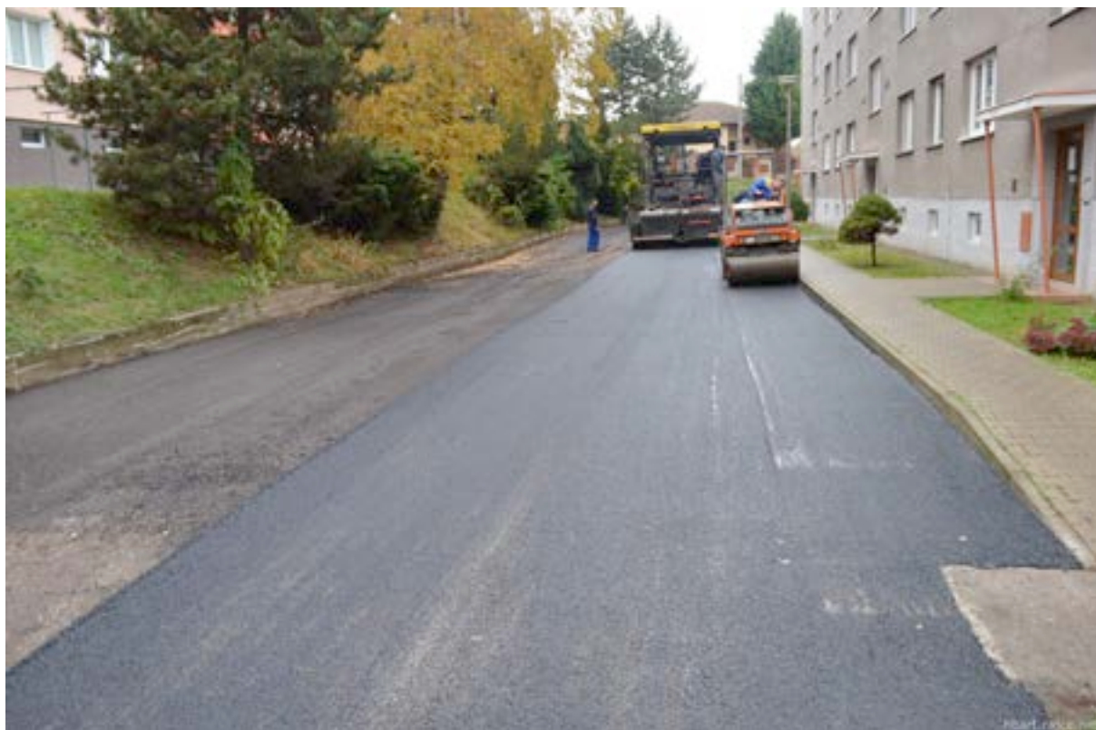
Výstavba komunikací v Libčicích nad Vltavou
