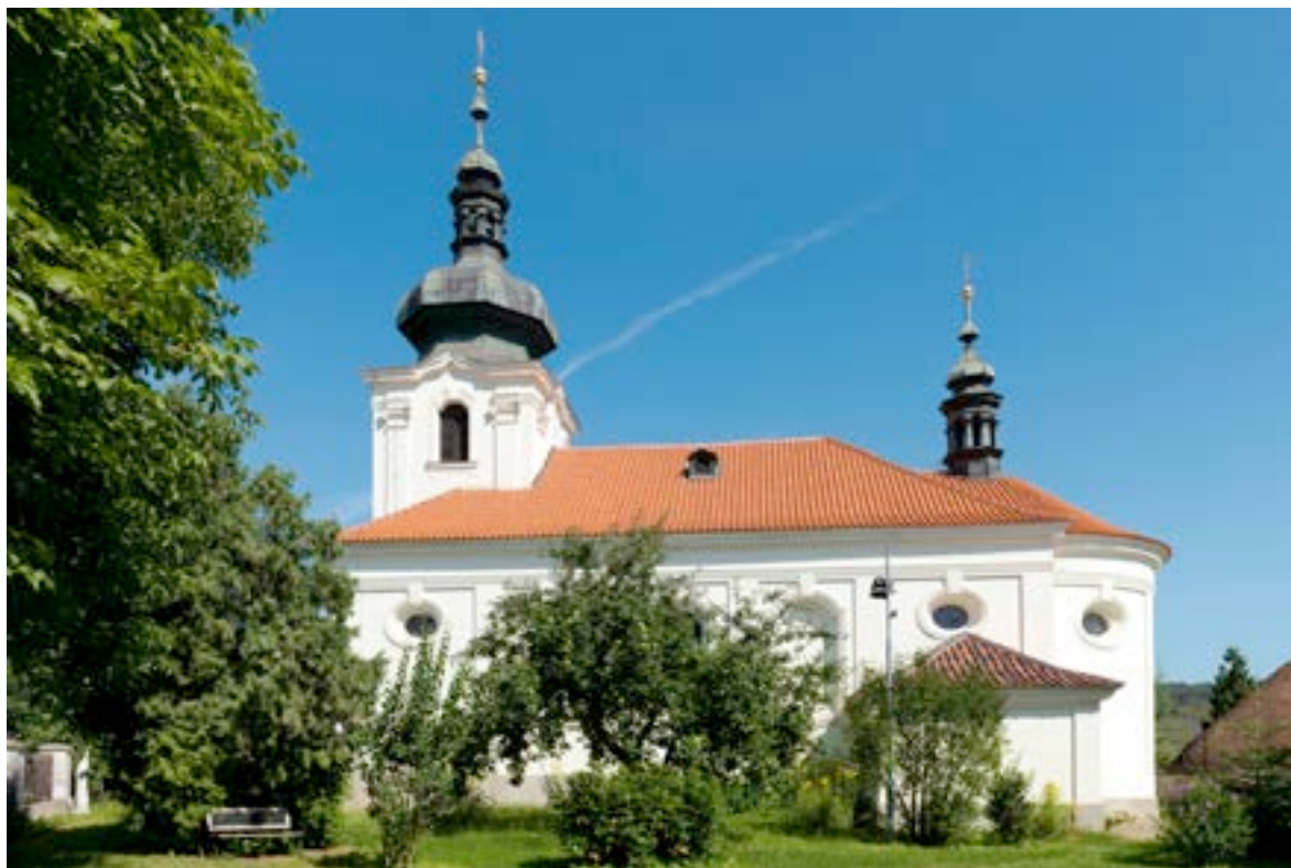
Opravený kostel sv. Bartoloměje (2014, foto Pavel Vychodil)
